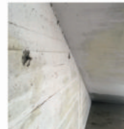
Incorporación de pintura bajo escalera de piso 1 a entrepiso, sector oeste
