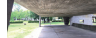
Vista general del sector (pilares sector norte)
