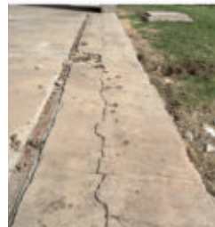
Ampliación contrapiso e insertos metálicos de reja perimetral retirada
