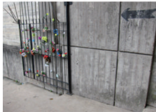
Puerta reja de control de acceso sobre gradonata
