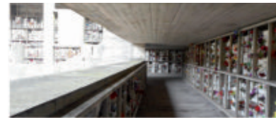
Vista general del sector
