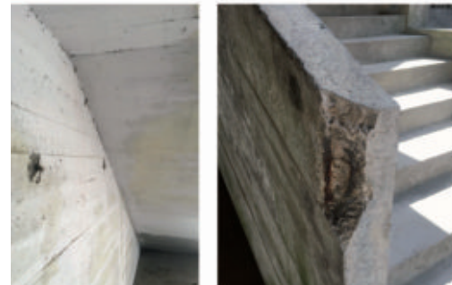
Incorporación de pintura bajo escalera
