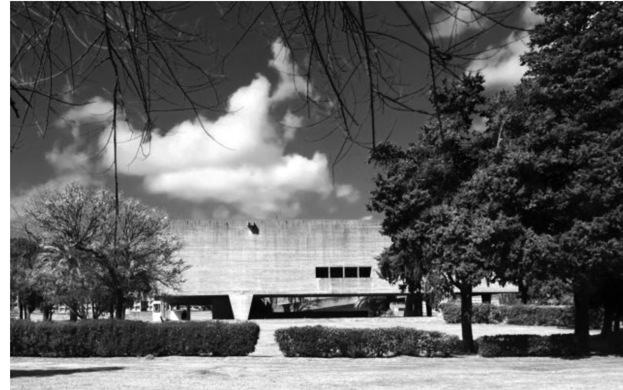
FIGURA 1. Vista del alzado norte desde los márgenes del lago. FOTOGRAFÍA: Jorge Gambini.
