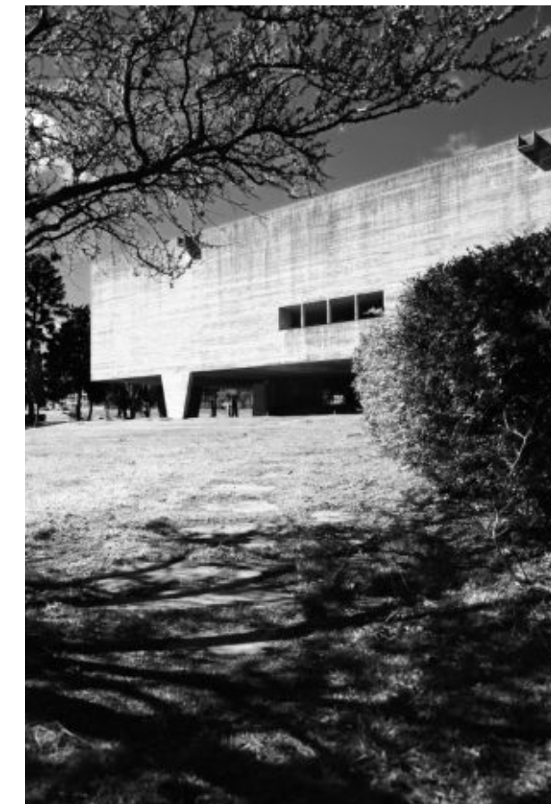
FIGURA 14. Vista de la arista sureste, tomada en horas matinales y con el muro pasante, a contraluz, que señala el acceso. FOTOGRAFÍA: Jorge Gambini.
