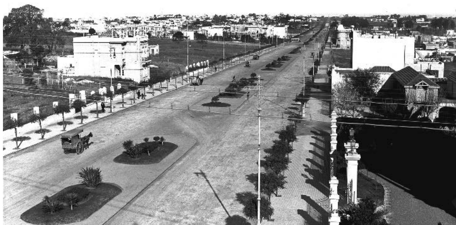
FIGURA 2. AVENIDA BULEVAR GENERAL ARTIGAS. BARRIOS PARQUE RODÓ Y POCITOS (C. 1916).
