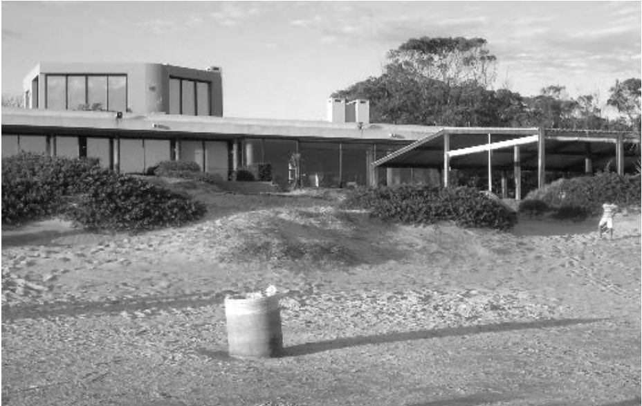
FIGURA 5. LA SOLANA BOUTIQUE HOTEL (RIENZL 2009). VISTA GENERAL.
