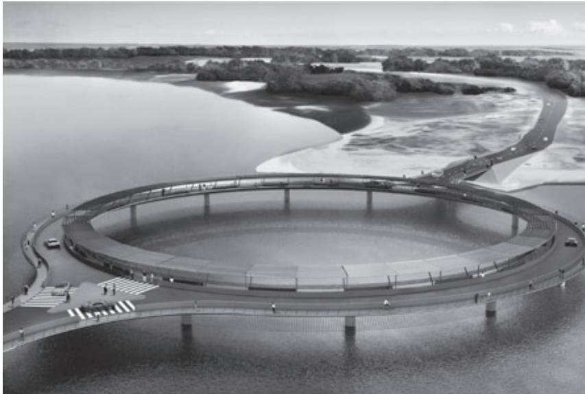
Futuro puente sobre laguna Garzón, proyecto de Rafael Viñoly.
