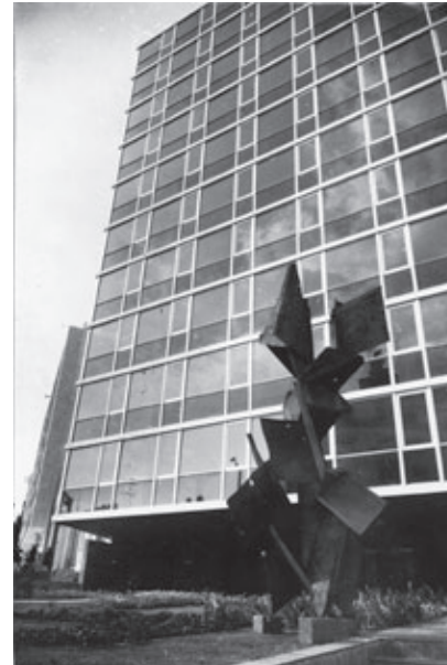
Luis García Pardo y Adolfo Sommer Smith. Edificio Positano. 1957-1963
