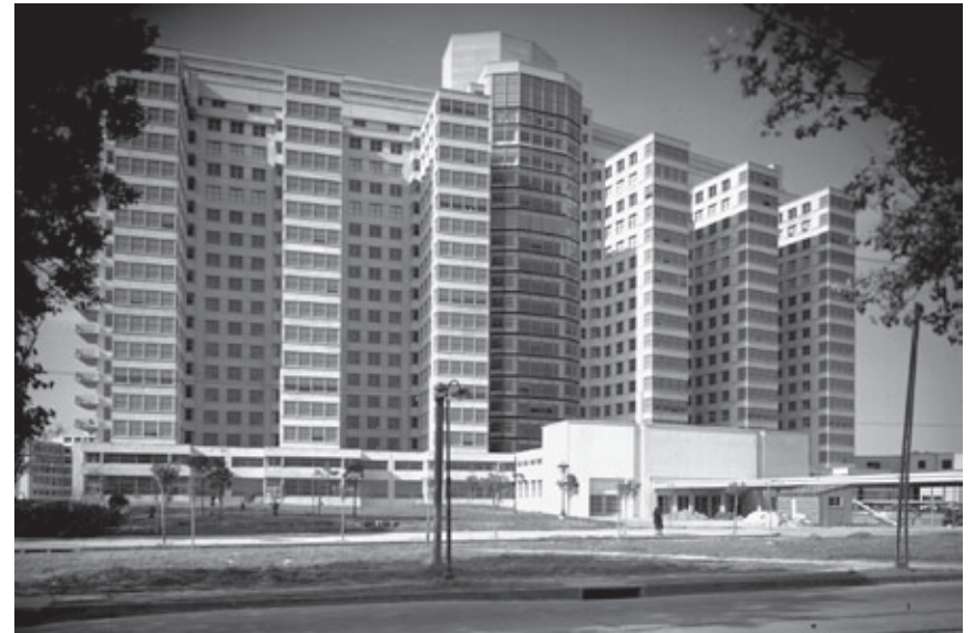
Fotografía de la fachada Norte
