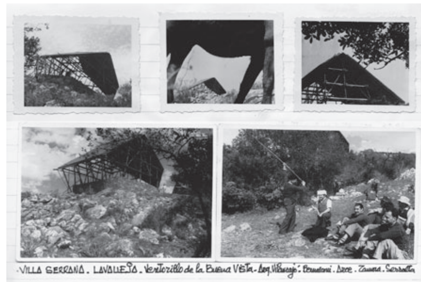
Visita al Ventorrillo de la Buena Vista en construcción, 1946.
