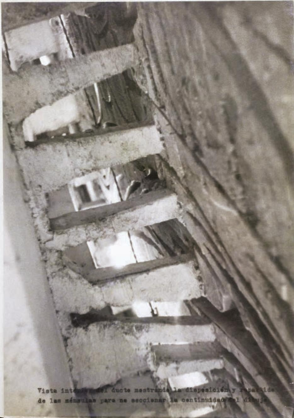
Vista interior del ducte mostrando la disposición y repartido de las ménsulas para no seccionar la continuidad del dibujo.
