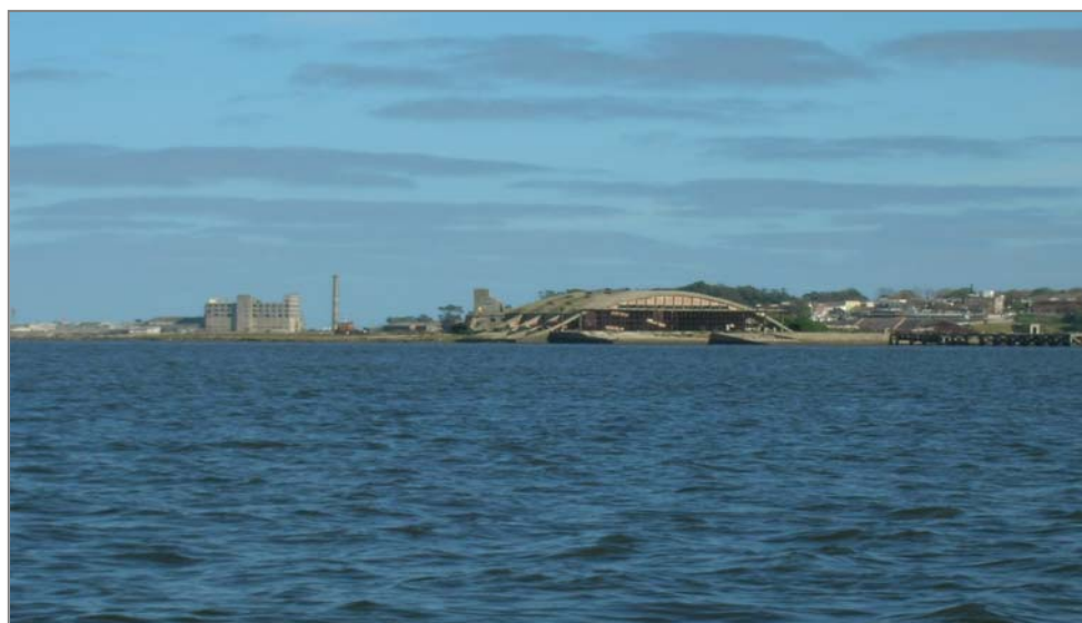
TERMINAL DE HIDROAVIONES EN LA BAHÍA DE MONTEVIDEO ©: Lina Sanmartín. Registro fotográfico de la bahía de Montevideo desde obras de Cerro Free Port a Escollera Sarandí. Junio de 2006
