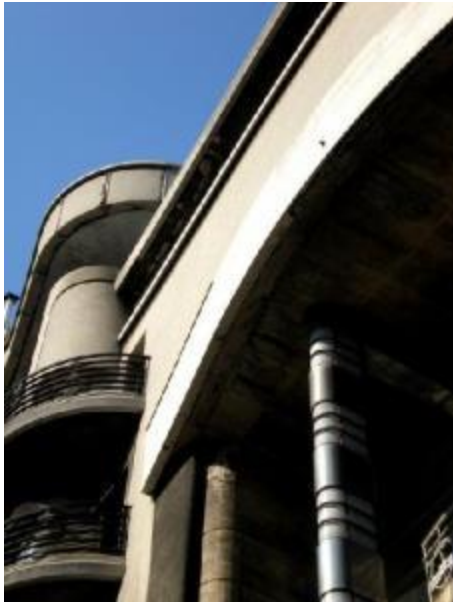
Fig.1. 23 _Edificio Confitería La Americana (E. Carlomagno, A. Bouza y E. González Fruniz, 1937). Recuperada el 30 de noviembre de 2013 de http://patrimoniomoderno.ort.edu.uy/front/documentos/38de2c_chica07-thumb.jpg
