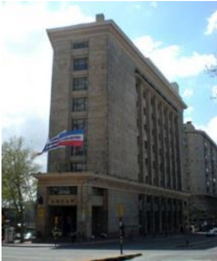
Fig.1.21 -ANCAP ( R.Lorente y R. Valenti, 1945). Recuperada el 30 de noviembre de 2013 de http://patrimoniomoderno.ort.edu.uy/front/documentos/ad0cd0_ppal.jpg
