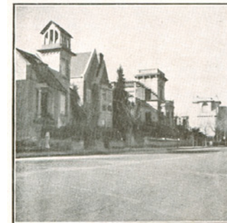
Desorden o falta de unidad se puede advertir en este conjunto de siete edificios de estilos diferentes. (Plaza J. P. Varela.)
