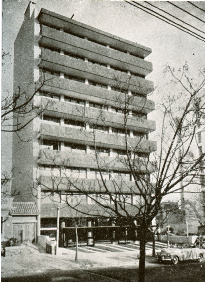
Edificio de apartamentos en Av. Soca 1163. Vista exterior. Planta baja y planta tipo. Arqs. Altamirano, Villegas Berro y Mieres Muró. (Revista "Arquitectura". Montevideo, 1954, N° 229, pp. 26 y 27)
