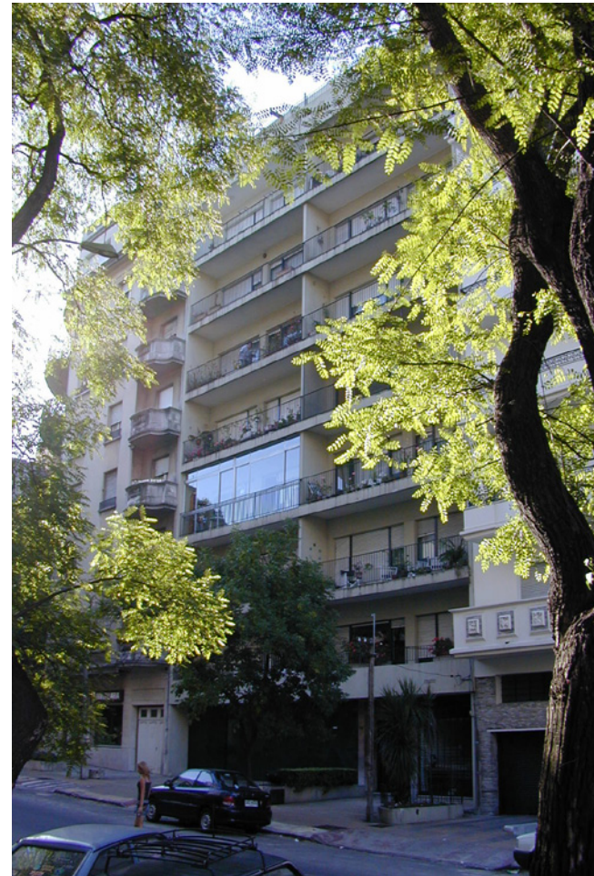
Utilización de similares recursos que en el edificio Guanabara, en un edificio que por su apariencia denota una “categoría” menos lujosa. Arq. R. Sichero. Calle L. Gadea entre Avda. Brasil y calle Cavia. (Foto SMA. Arq. Marcovecchio)
