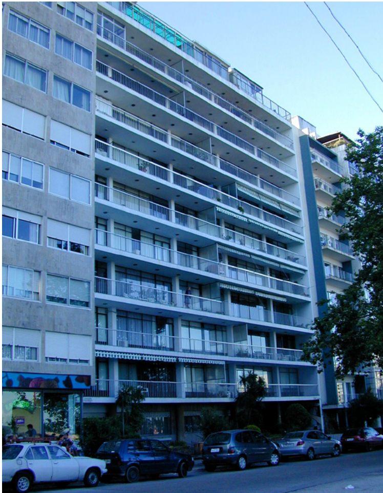
Tramo de la calle J. Benito Blanco que incorpora en su perfil al edificio Guanabara. Es este un buen ejemplo de la caracterización que asumen numerosos edificios de distintos autores, contribuye a la misma la disposición de amplias terrazas voladas sobre el retiro, mediando entre el espacio interior y la calle. Arq. L. García Pardo. (Foto SMA. Arq. Marcovecchio)
