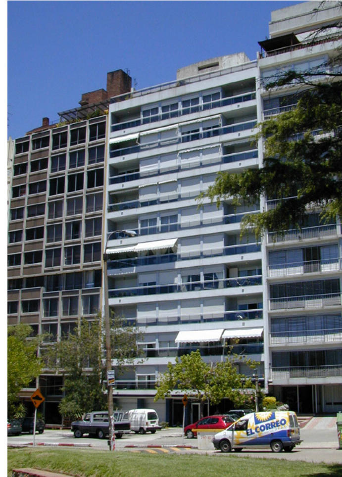
Edificio Pinares. Arqs. Mazzini y Albanell Mc Coll. Leyenda Patria 2930. (Foto SMA. Arq. Marcovecchio)
