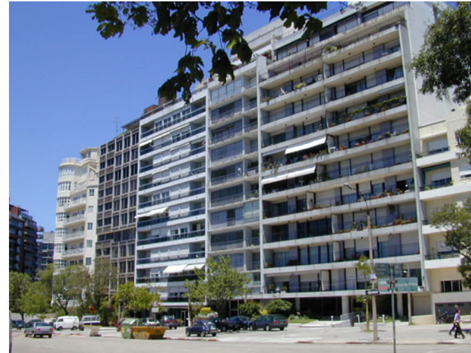
Borde configurado por la coexistencia de edificios de apartamentos en altura de distintas épocas (1940 a 1990). Calle Leyenda Patria frente al Parque Zorrilla de San Martín. (Foto SMA. Arq. Marcovecchio)
