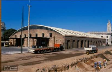
12.Depósito Puerto SMA-S148-012.
