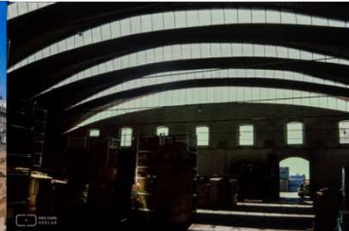
13.Depósito Puerto SMA-S148-013
