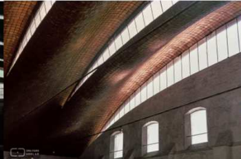
14.Depósito Puerto SMA-S148-014
