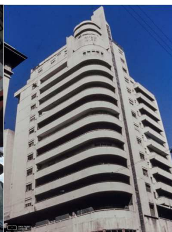
10. Edificio Lapido SMA-S072-010
