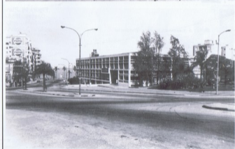
Figura 94. Mercado Central. Proyecto del Arq. E. Monestier para conservar parte del antiguo edificio integrado al nuevo Figura 95. Mercado Central. La demolición del viejo mercado generó un vacío urbano.
