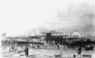
Figura 29. Conjunto formado por el muelle, la playa natural y el edificio de la Aduana, que cumplían las funciones de puerto.
