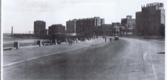
Figura 74. Lugar donde se iniciaron las obras de la Rambla Sur, se observa la edificación desaparecida.
