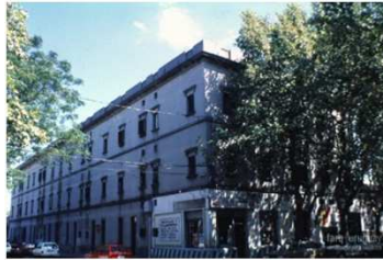
57a. Galería Ferro-Pitaluga SMA-S184-057a
