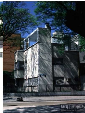
29.Vivienda Valerio Souto SMA-S184-029
