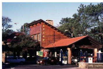
45. Estación ANCAP SMA-S184-045
