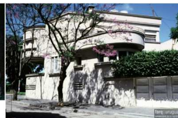
28.Vivienda Crespi SMA-S184-028
