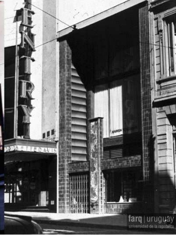
12. Almacén anexo Conf. SMA-S184-012
