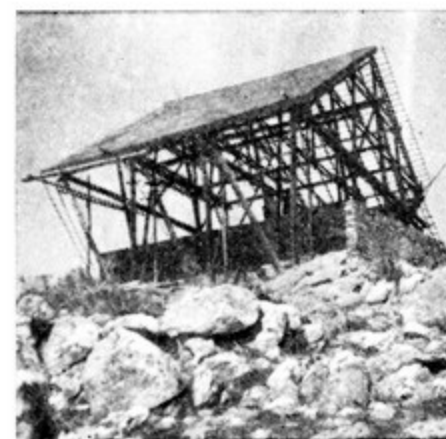
20 y 21.— VENTORRILLO DE LA BUENA VISTA. Comedor. Estructura y cubiertas. Villa Serrana.
