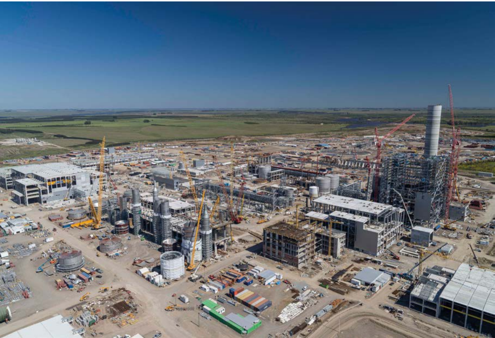
FOTO Zona obra UPM 2. Andrés Bartet
