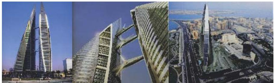
Densidad: 3 turbinas /Potencia: 1100 - 1300 MW/año /Diseño: diametro: 29m - diseñadas para minimizar vibraciones y ruidos
