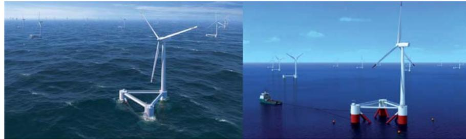
Densidad: 1 Turbina /Potencia: 2 MW /Diseño: plataforma flotante para turbina eólica, se soporta en tres columnas con trampas de agua en la base que le otorgan estabilidad estática y dinámica. Diametro de rotor 120-170m/Altura del buje de la turbina 80/90m/Profundidad de servicio > a 50m/Componentes convencionales de amarre 4 líneas/Color blanco /Estudio Ambiental: - /Estudio Paisajístico: -
