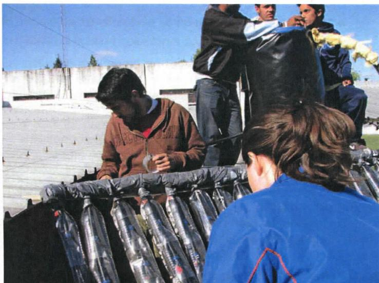
Fig. 30. Colocación de aislante térmico en el sistema.
