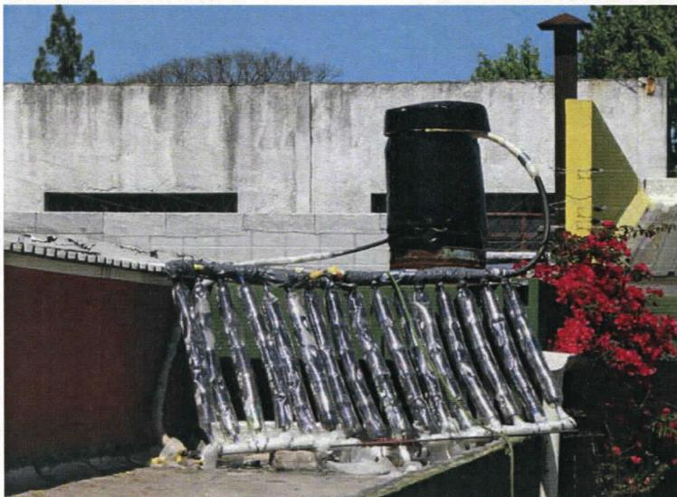
Fig 20. Colector dinámico realizado por los alumnos y los constructores
