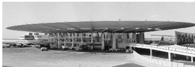
Techo elíptico colgado de cables Acceso a Aeropuerto JFK New York
