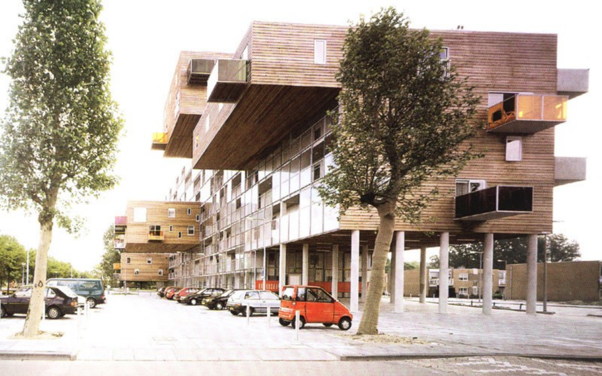
Edificio Wozoco's - Amsterdam 1997 - MVRDV
