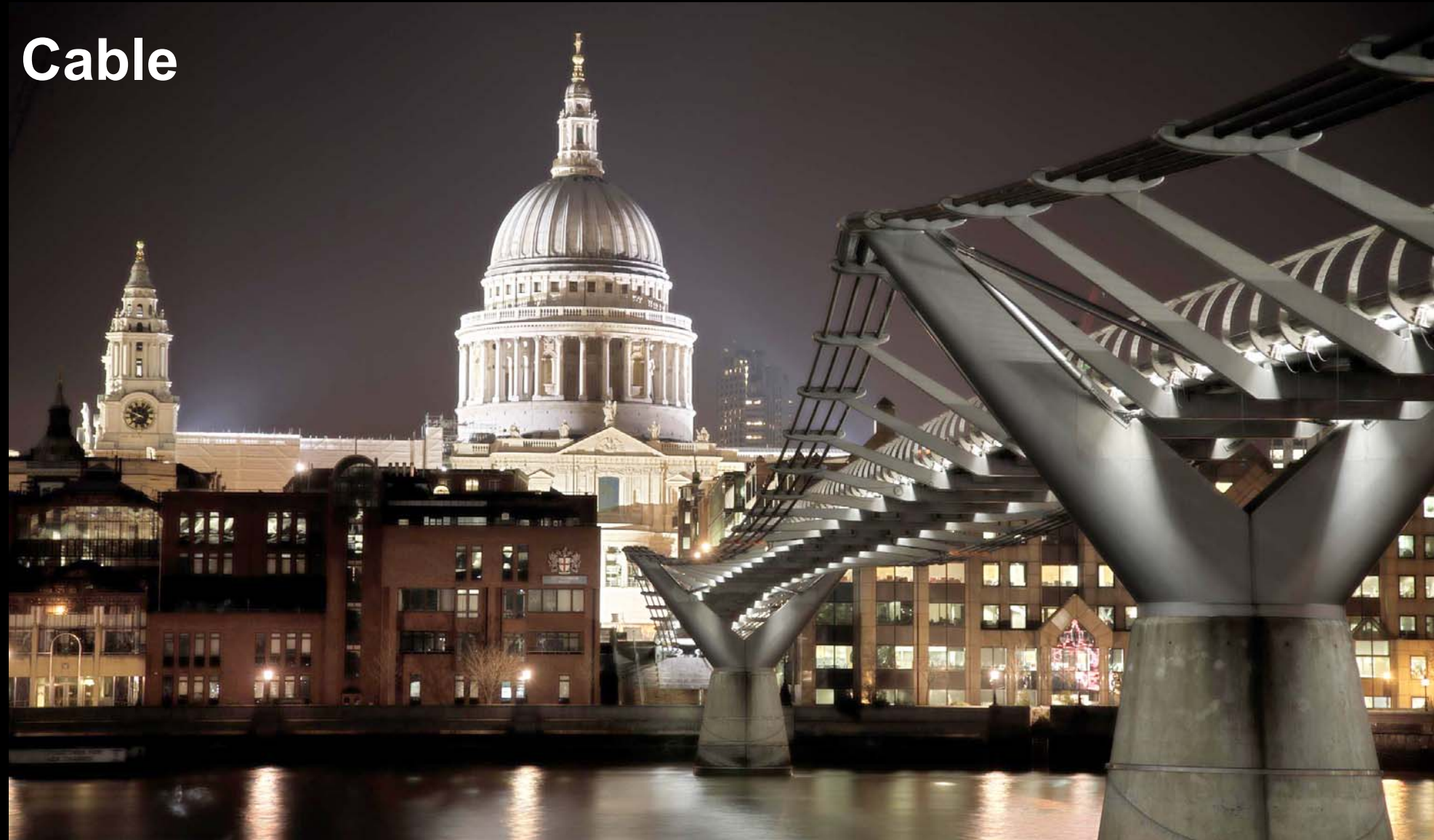
Proyecto: Millennium Bridge [2000] Foster & Partners
