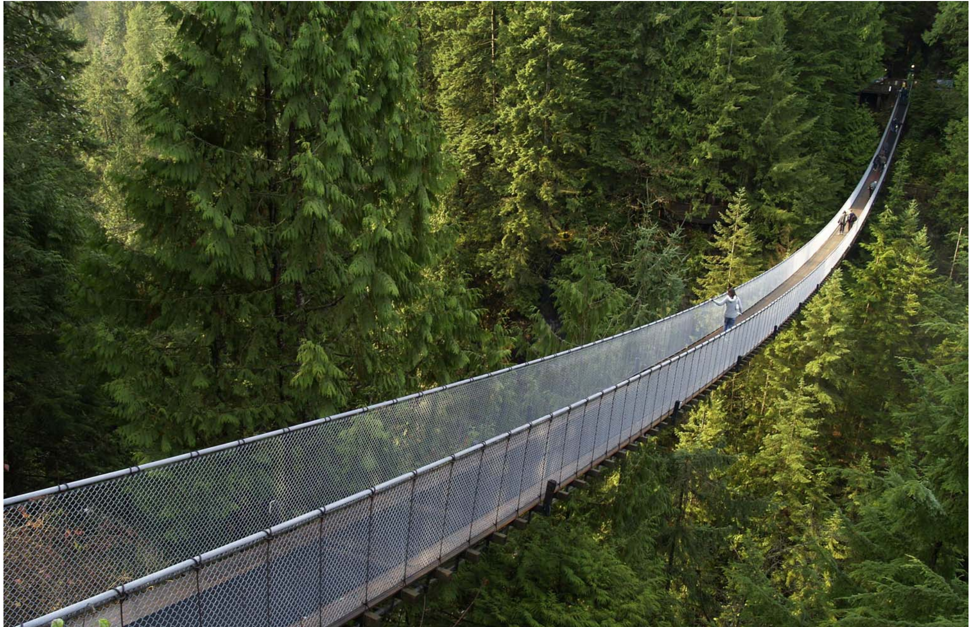
Proyecto: Capilano Suspension Bridge [1889] George Grant Mackay
