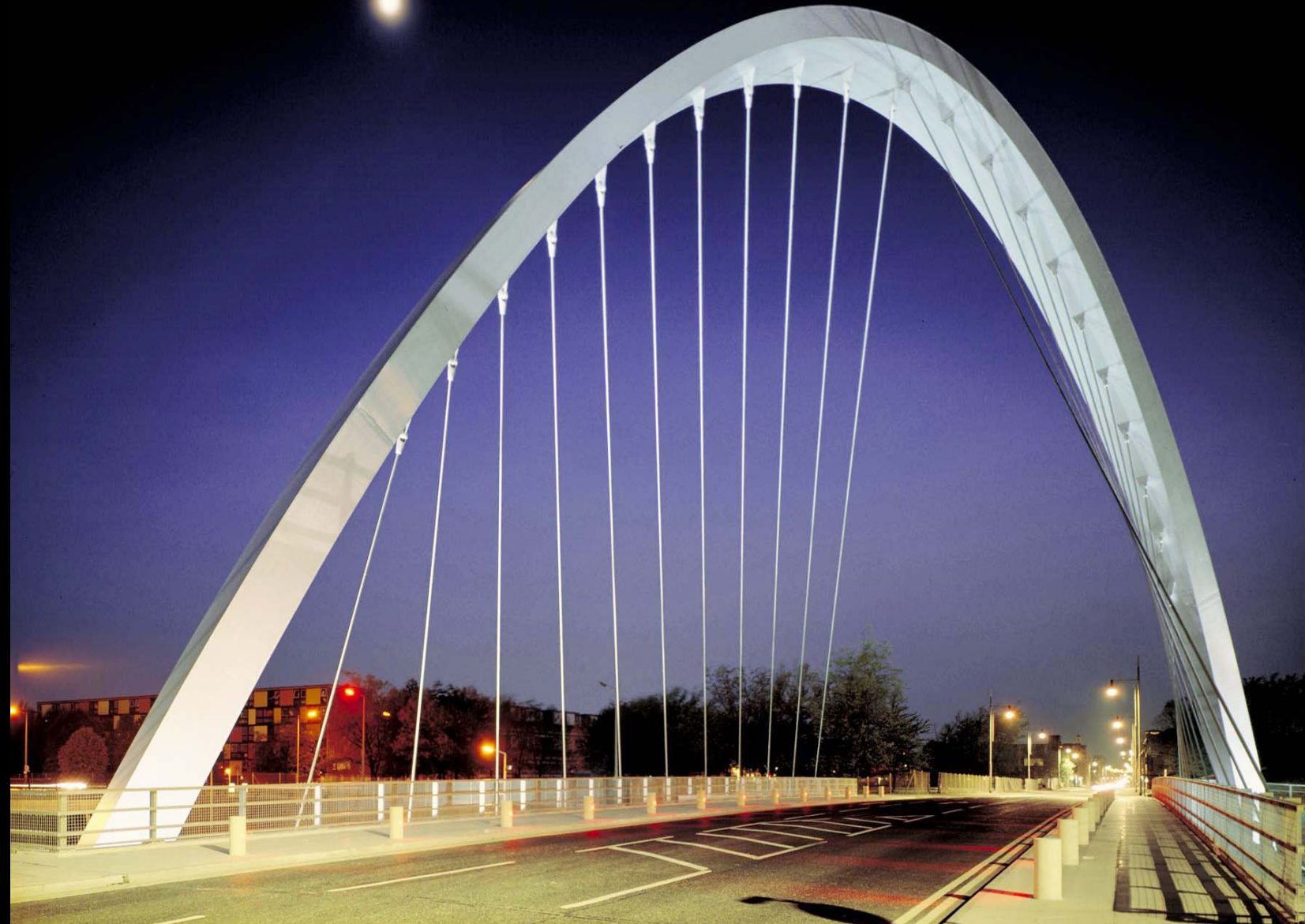
Proyecto: Hulme Bridge [1997] Keith Brownlie
