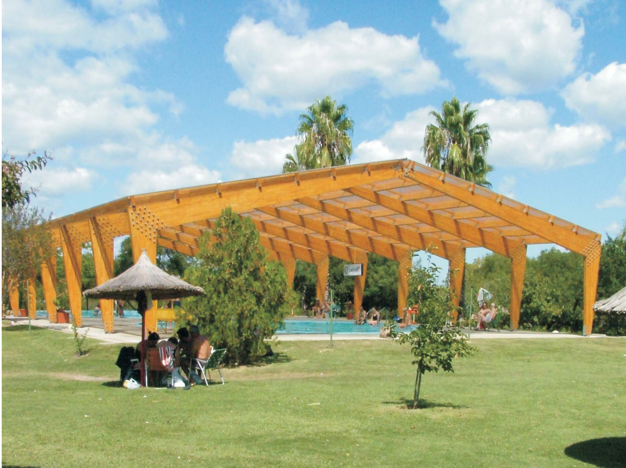
Piscina cubierta en Termas del Daymán, Salto
