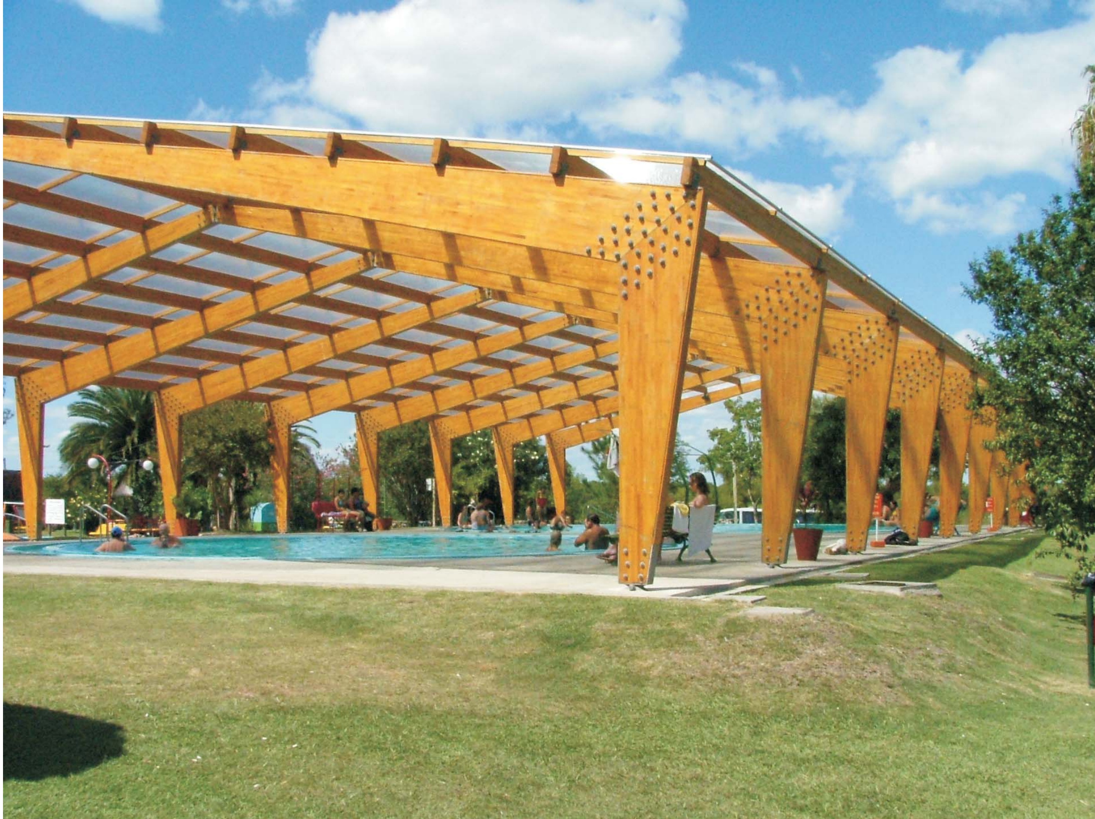
Piscina cubierta en Termas del Daymán, Salto
