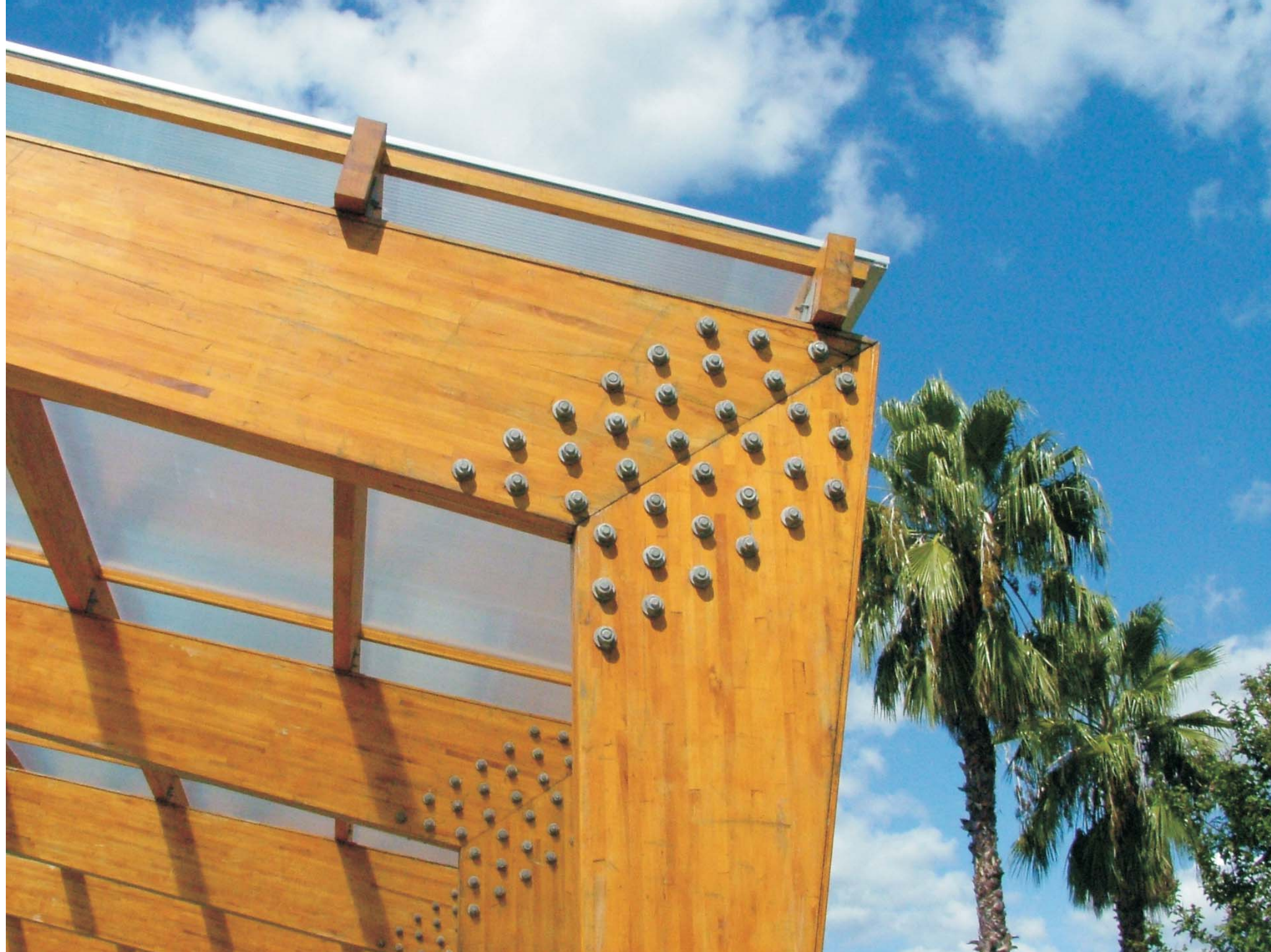
Piscina cubierta en Termas del Daymán, Salto
