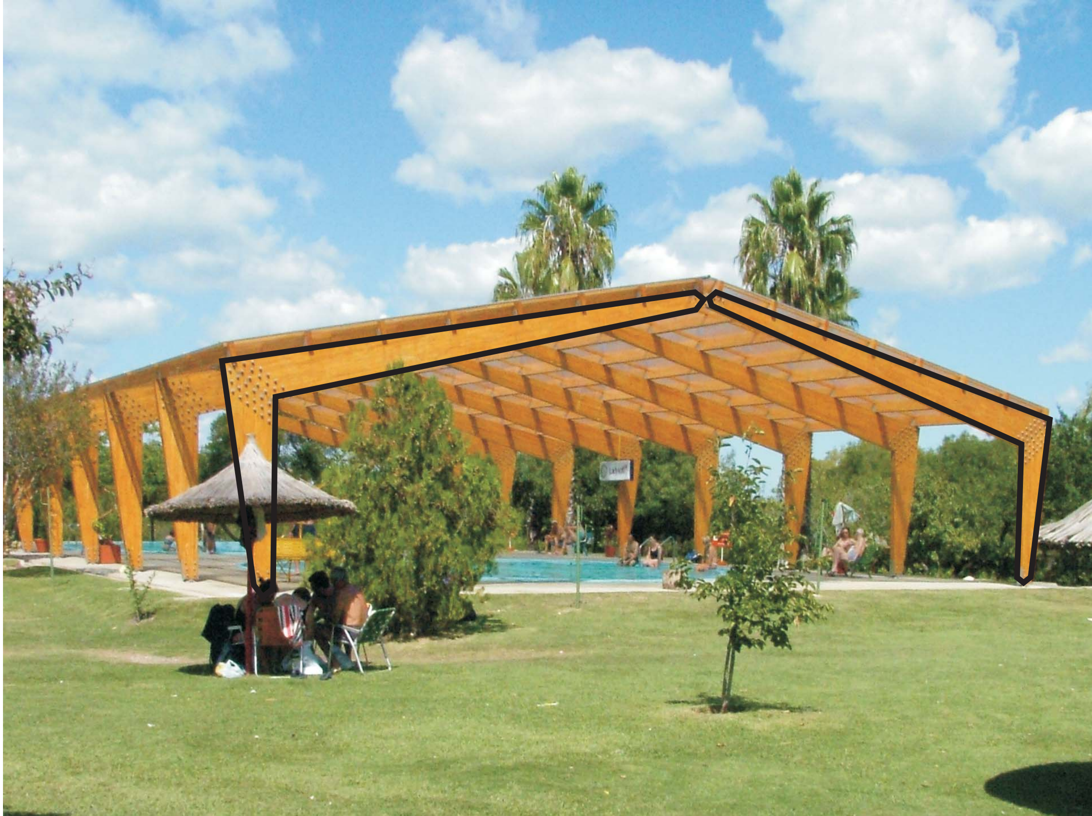
Piscina cubierta en Termas del Daymán, Salto
