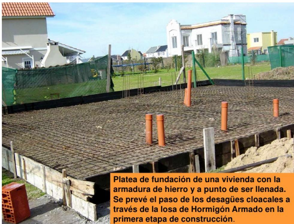
**Plata de fundación de una vivienda con la armadura de hierro y a punto de ser llenada. Se prevé el paso de los desagües cloacales a través de la losa de Hormigón Armado en la primera etapa de construcción.**
