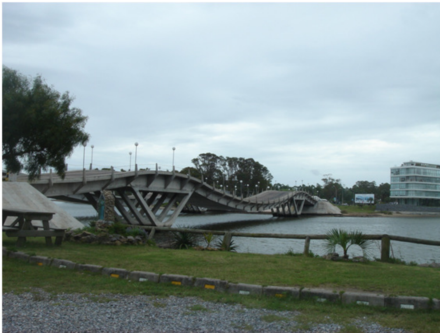
PUENTE DE LA BARRA (MALDONADO) VIERA - 1963
